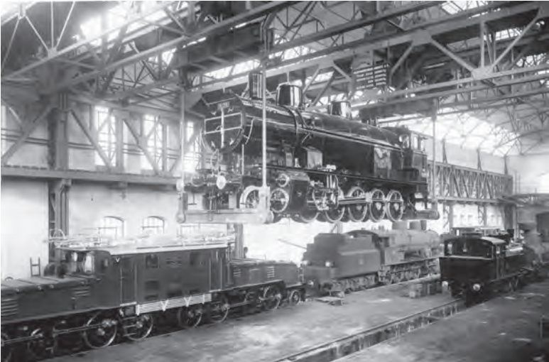
Einer der 60 Tonnen-Kräne
