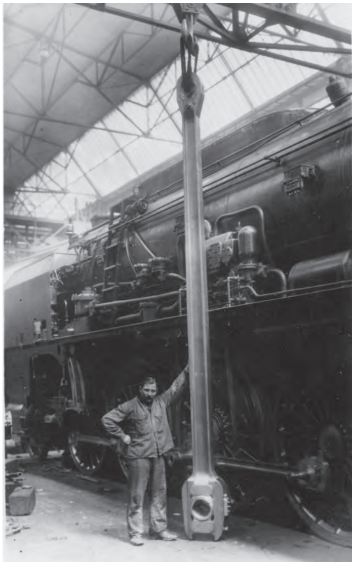
Treibstange für die 1D2-Heissdampf-Zwillings-Schnellzugslokomotive Reihe 214; gebaut 1928–1936.
