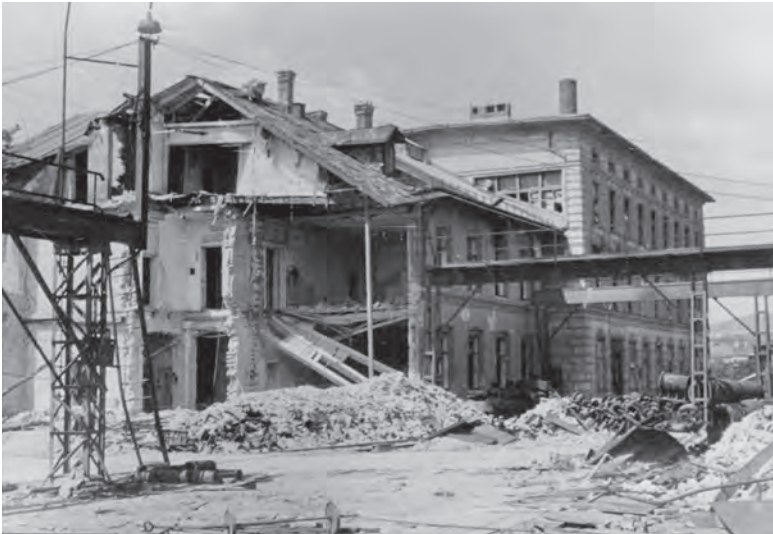
Bombenschäden auf dem Gelände der Lofag
