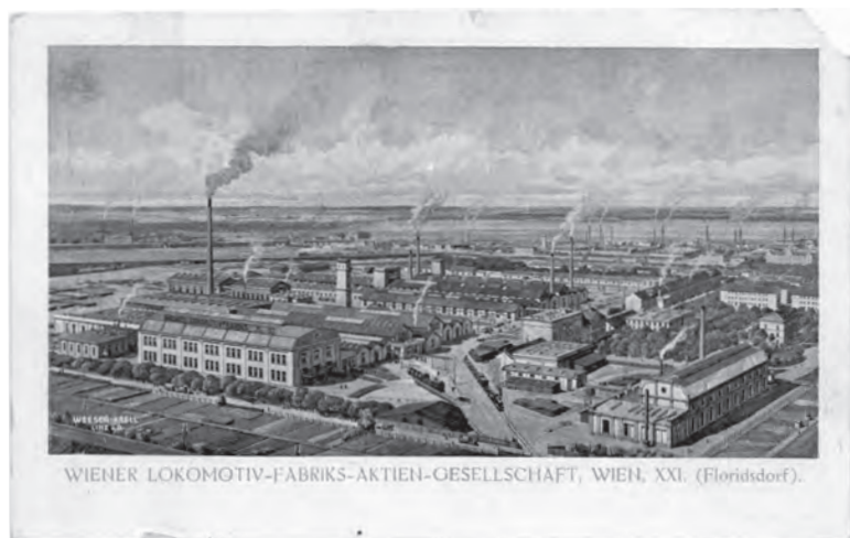
Das Fabriksgelände der Floridsdorfer Lokomotivfabrik auf einer frühen Postkartenansicht.
